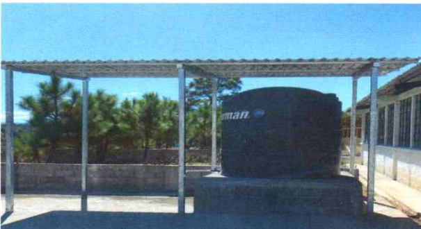
Foto 3: Estructura de Soporte de metal galvanizada Instalada
