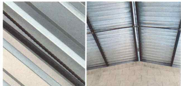
Foto 2: Cubierta de lámina instalada
