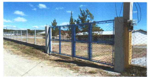
Foto 4: Portón de tubo y malla instalando en la entrada peatonal del centro Educativo
